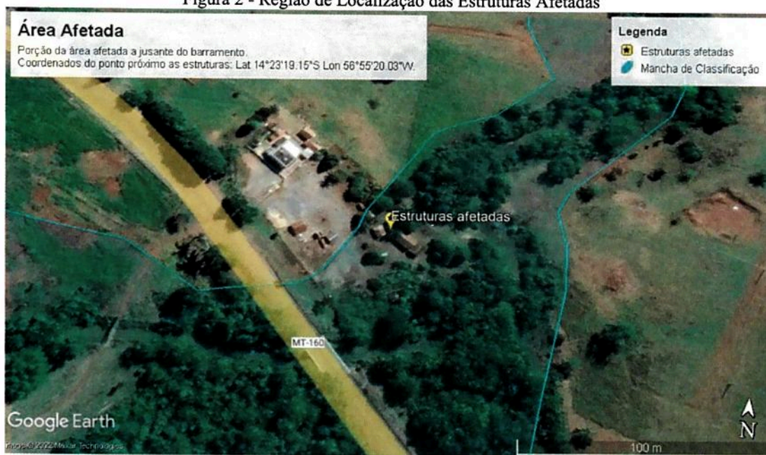
Figura 2 - Região de Localização das Estruturas Afetadas
